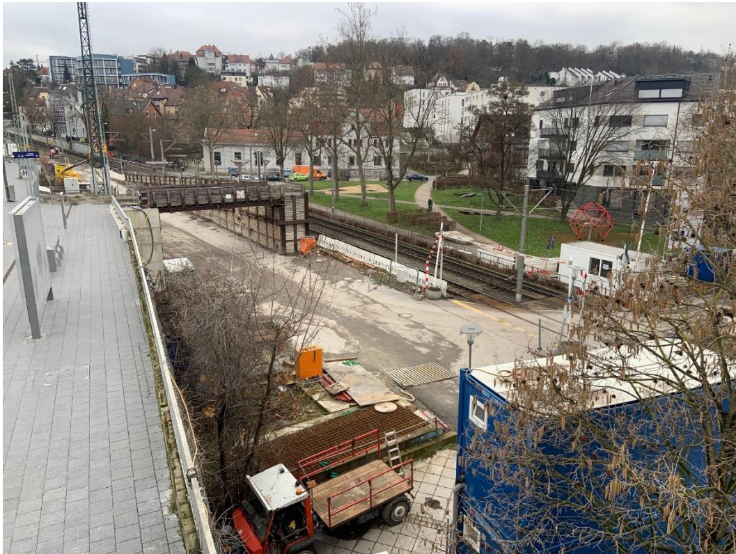
Abbildung 2: Blick auf das Baufeld bei Messende am 06.02.2023
