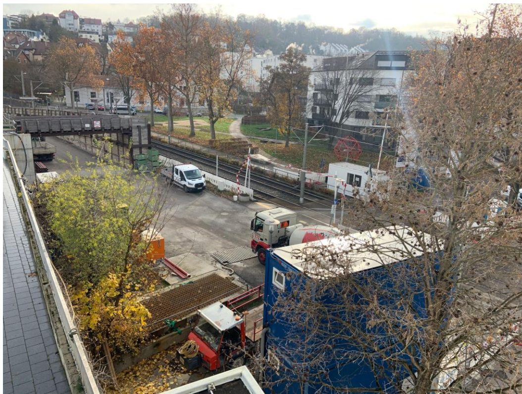
Abbildung 2: Blick auf das Baufeld bei Messende am 05.12.2022
