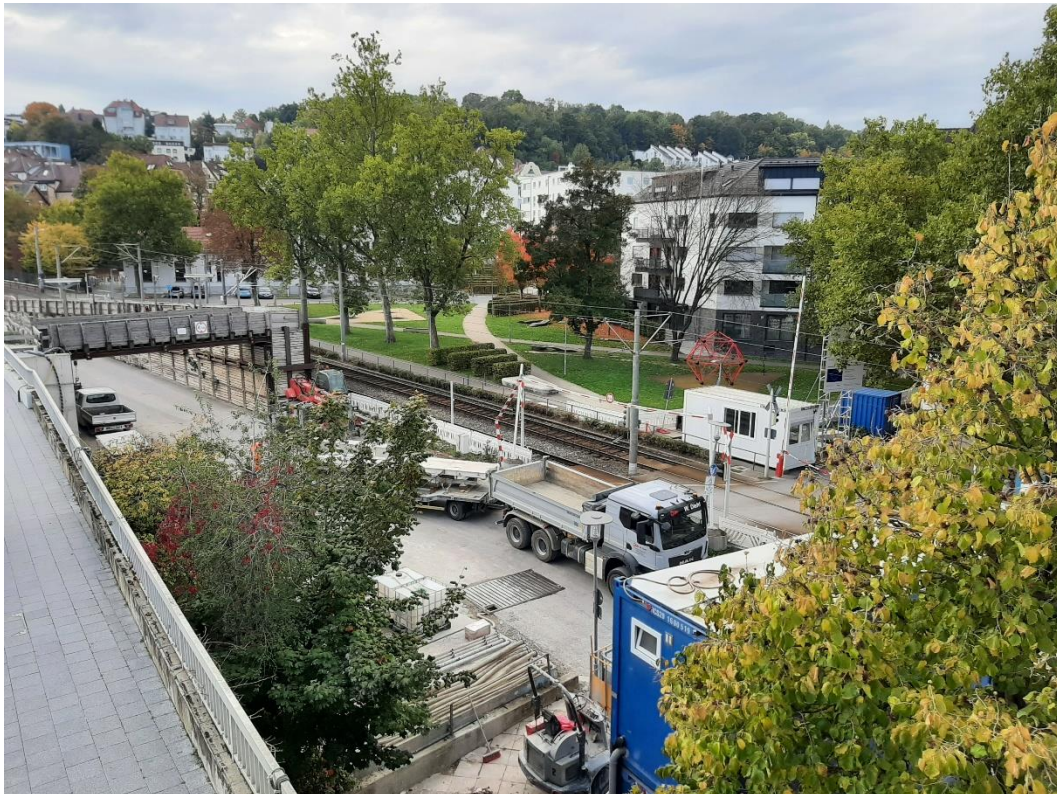
Abbildung 2: Blick auf das Baufeld bei Messende am 10.10.2022
