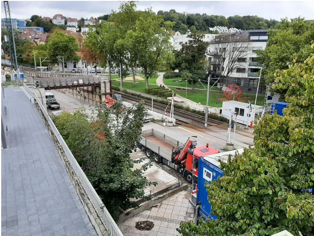
Abbildung 2: Blick auf das Baufeld bei Messende am 19.09.2022
