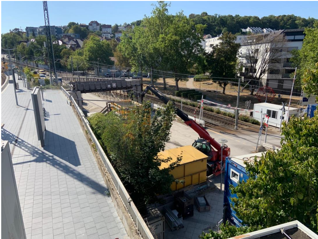
Abbildung 2: Blick auf das Baufeld bei Messende am 22.08.2022
