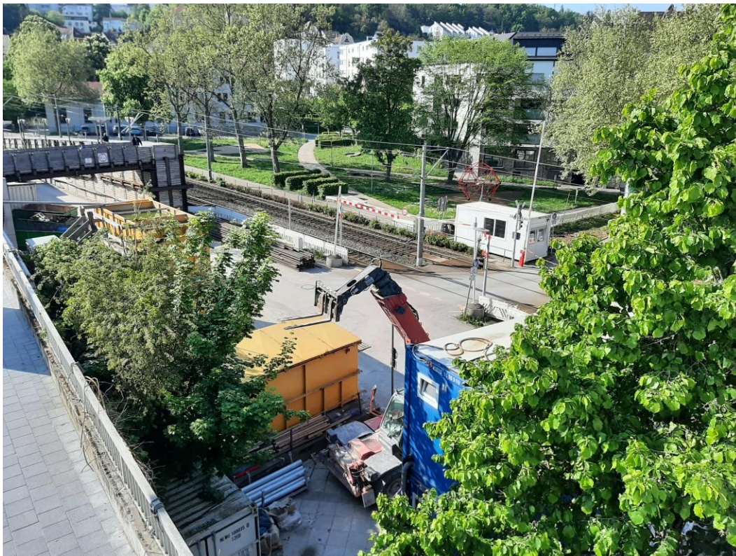
Abbildung 2: Blick auf das Baufeld bei Messende am 09.05.2022
