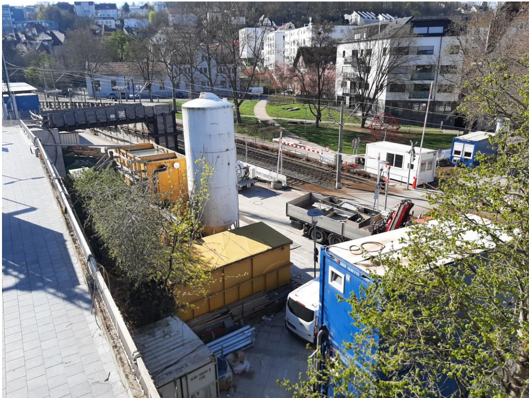
Abbildung 2: Blick auf das Baufeld bei Messende am 11.04.2022
