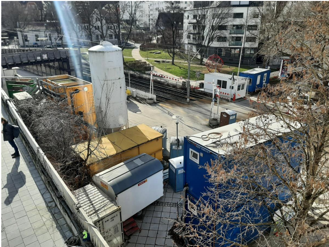
Abbildung 2: Blick auf das Baufeld bei Messende am 21.02.2022
