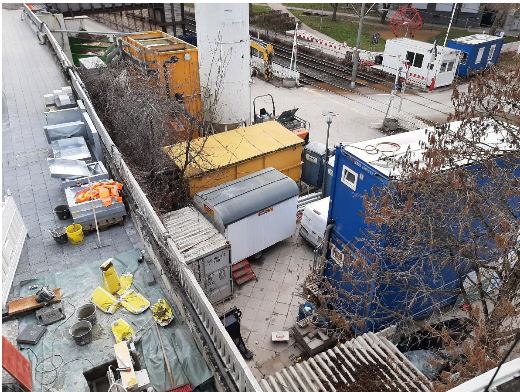
Abbildung 1: Blick auf das Baufeld bei Messbeginn am 14.02.2022
