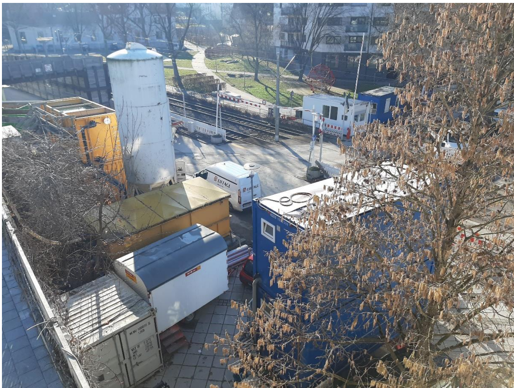
Abbildung 1: Blick auf das Bau- feld bei Messbeginn am 24.01.2022
