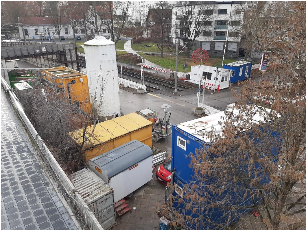
Abbildung 2: Blick auf das Baufeld bei Messende am 31.01.2022
