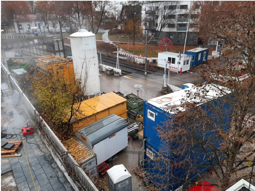
Abbildung 2: Blick auf das Baufeld bei Messende am 22.10.2021
