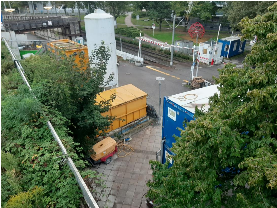
Abbildung 2: Blick auf das Baufeld bei Messende am 23.08.2021
