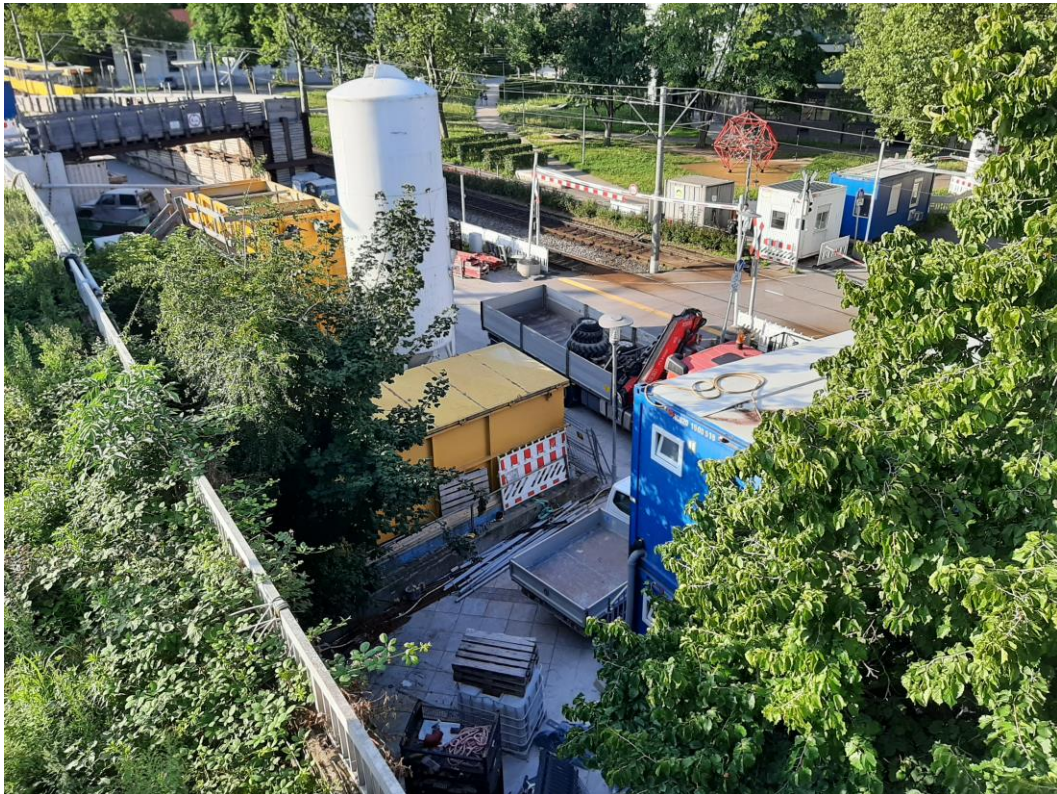
Abbildung 2: Blick auf das Baufeld bei Messende am 19.07.2021
