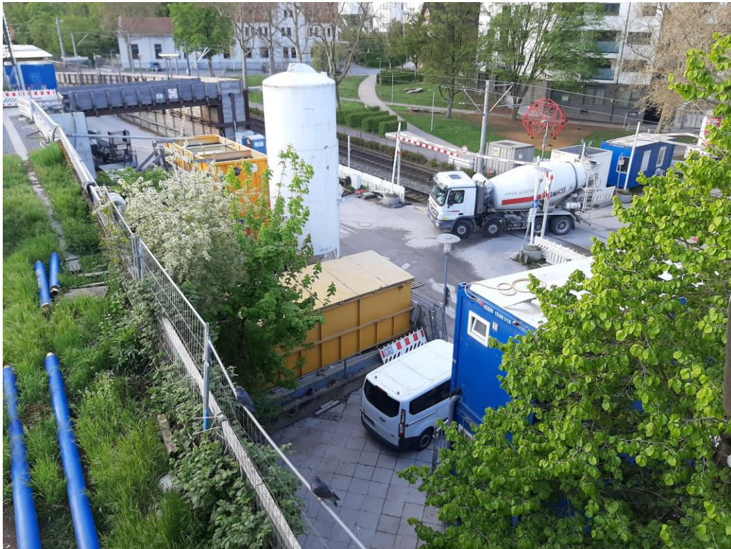
Abbildung 2: Blick auf das Baufeld bei Messende am 03.05.2021
