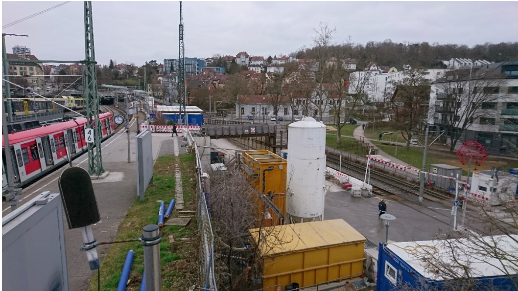
Abbildung 2: Blick auf das Baufeld bei Messende am 22.03.2021
