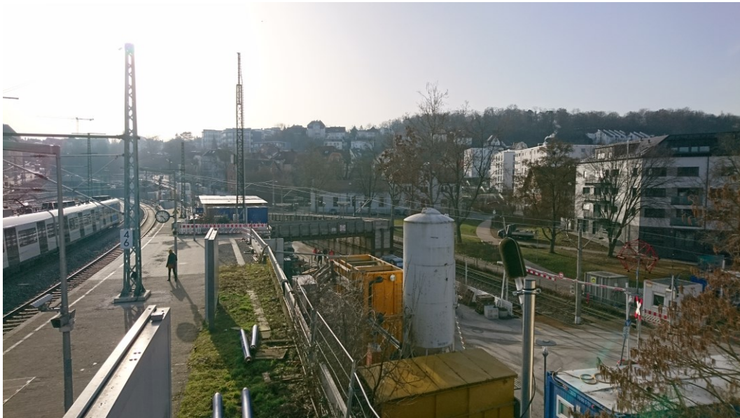
Abbildung 2: Blick auf das Baufeld bei Messende am 22.02.2021
