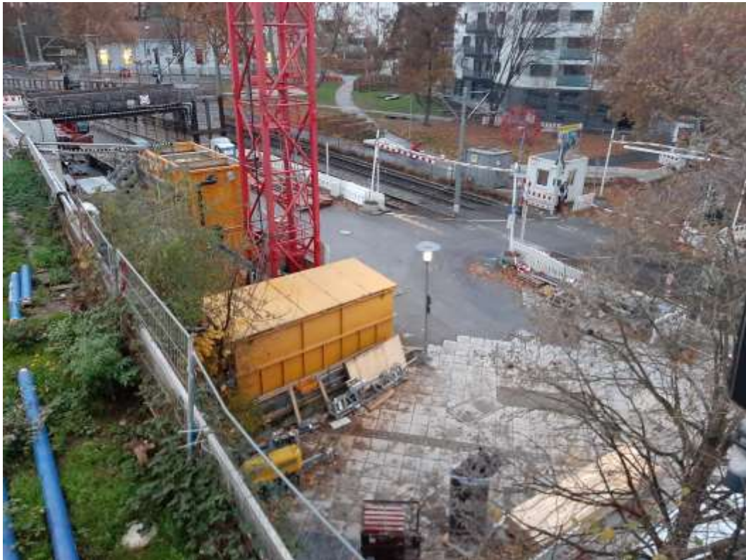
Abbildung 2: Blick auf das Baufeld bei Messende am 16.11.2020
