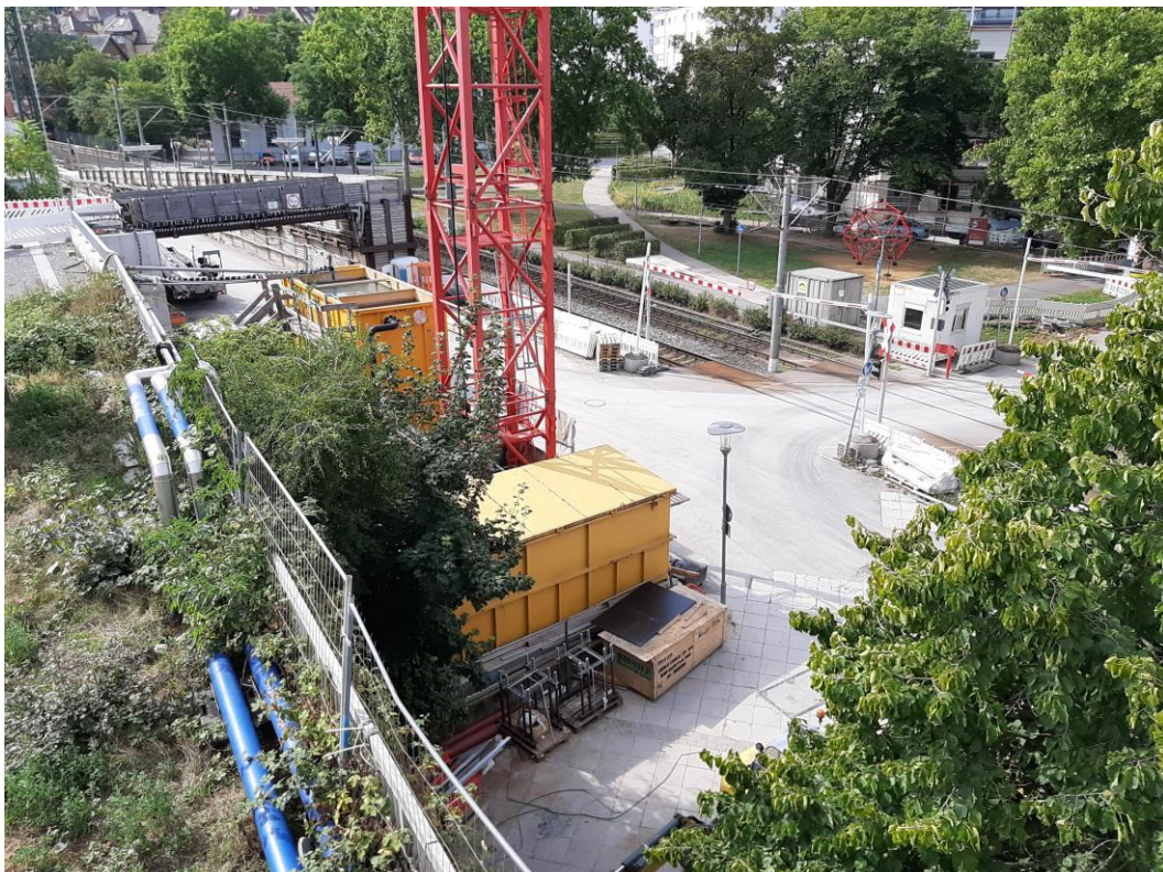
Abbildung 1: Blick auf das Baufeld bei Messbeginn am 03.08.2020
