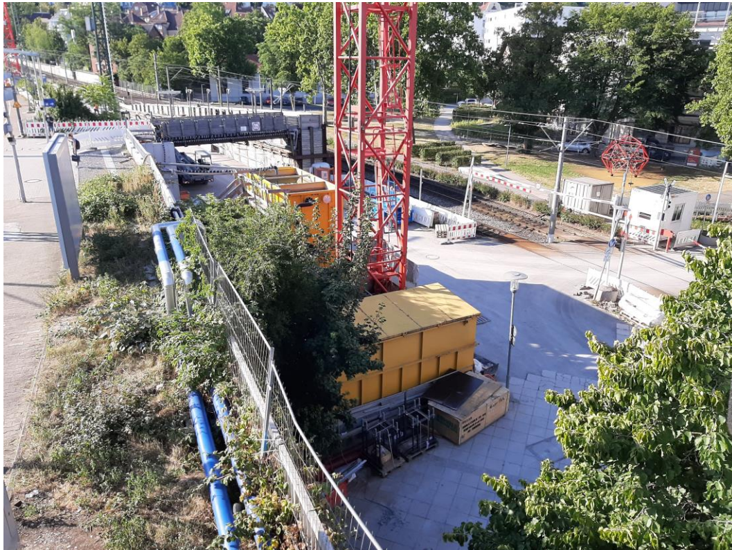
Abbildung 2: Blick auf das Baufeld bei Messende am 12.07.2020
