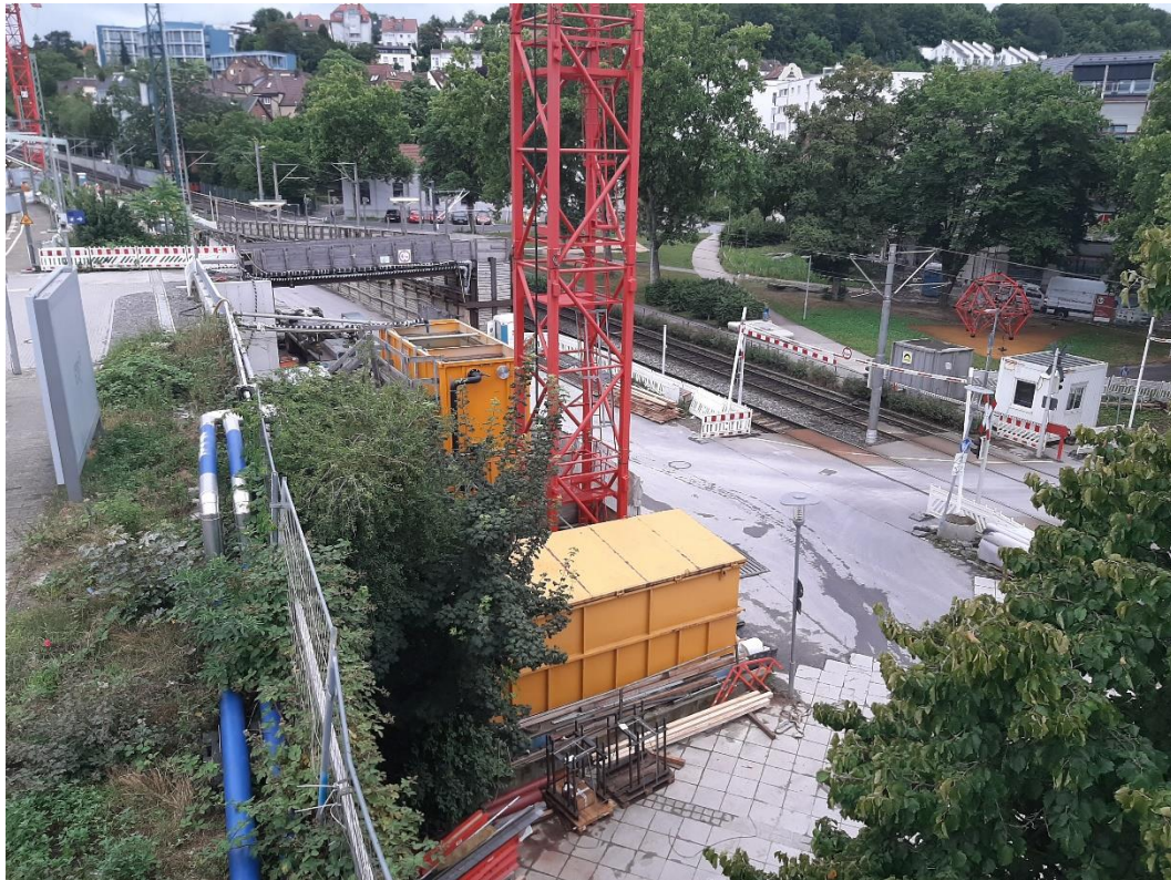
Abbildung 2: Blick auf das Baufeld bei Messende am 28.06.2020
