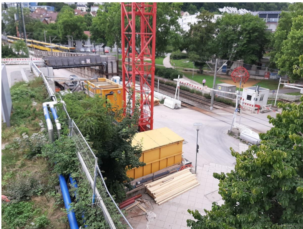
Abbildung 1: Blick auf das Baufeld bei Messbeginn am 22.06.2020
