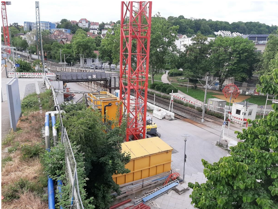
Abbildung 2: Blick auf das Baufeld bei Messende am 23.05.2020
