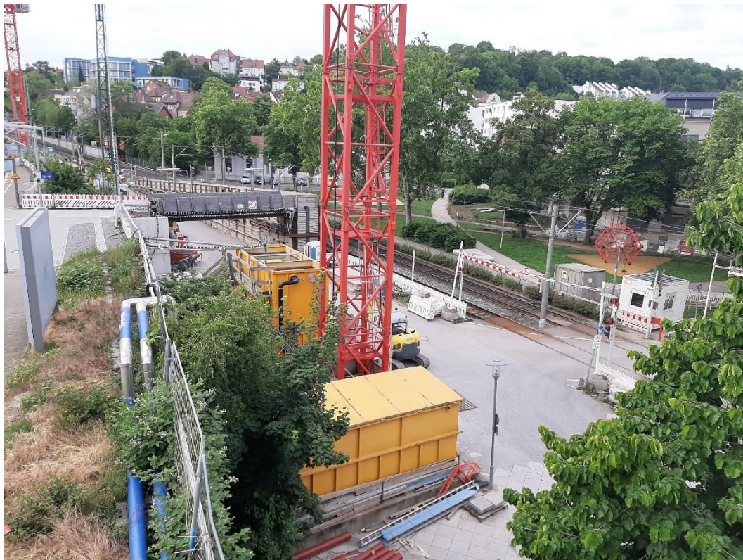
Abbildung 2: Blick auf das Baufeld bei Messende am 04.05.2020
