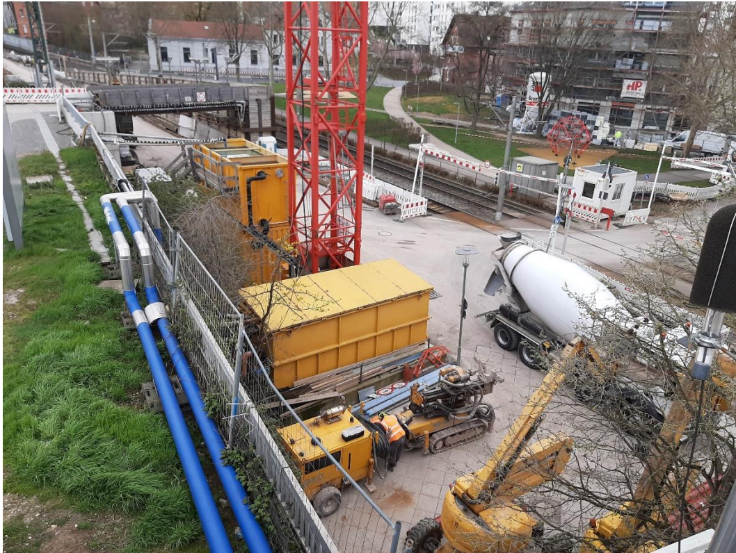
Abbildung 2: Blick auf das Baufeld bei Messende am 14.04.2020
