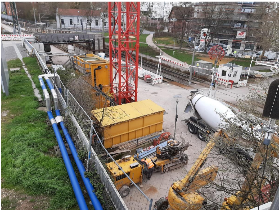
Abbildung 2: Blick auf das Baufeld bei Messende am 31.03.2020
