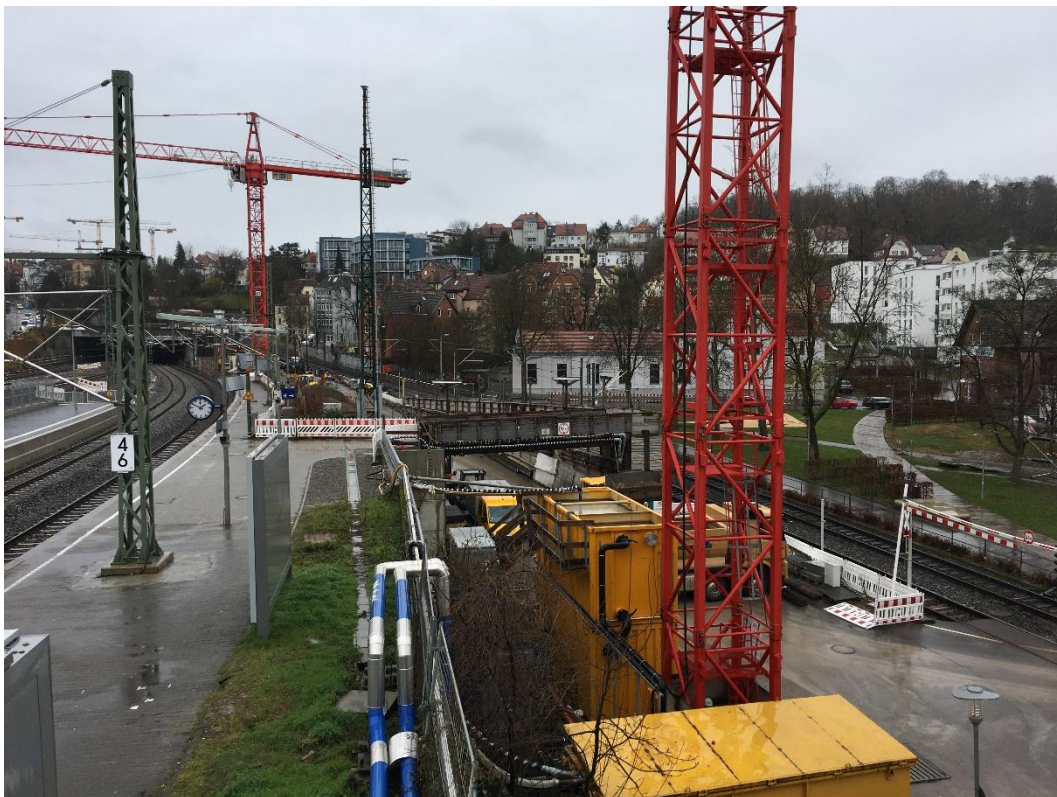
Abbildung 2: Blick auf das Baufeld bei Messende am 10.03.2020
