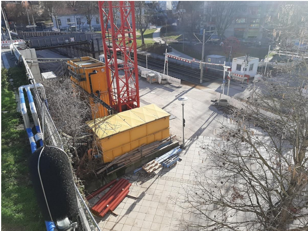
Abbildung 2: Blick auf das Baufeld bei Messende am 05.02.2020
