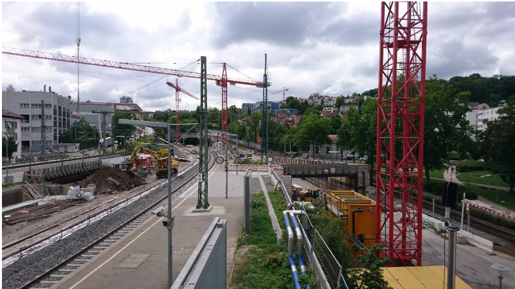
Abbildung 2: Blick auf das Baufeld bei Messende am 25.06.2018
