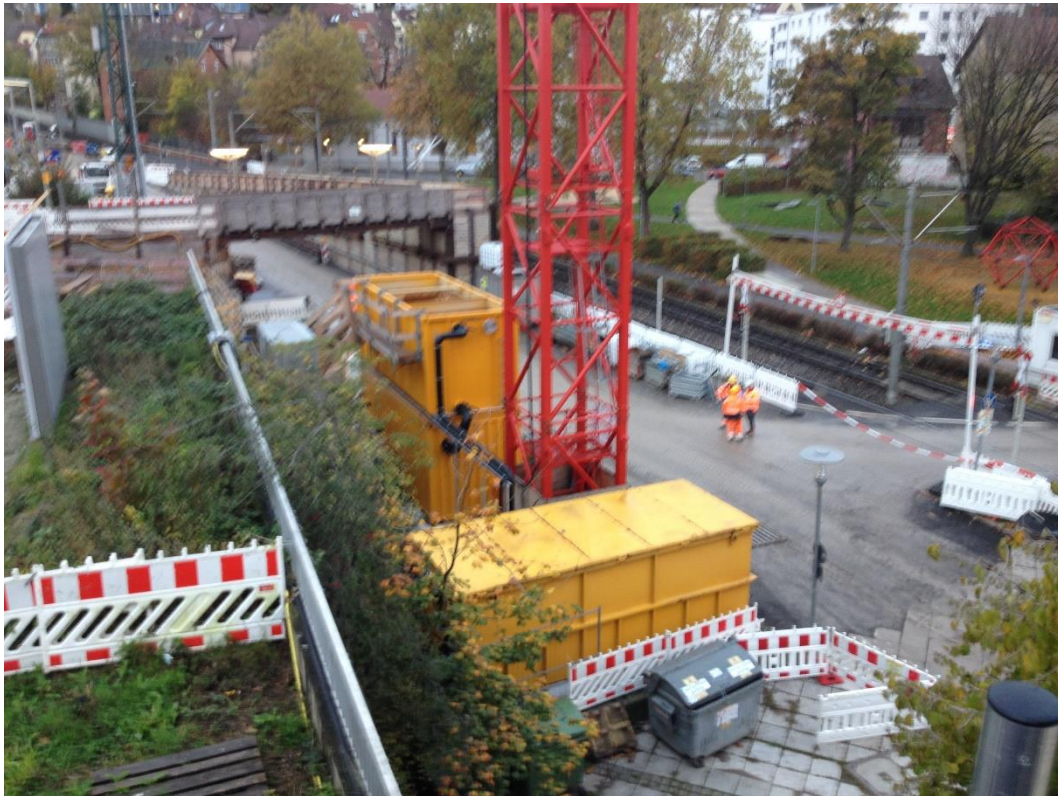
Abbildung 2: Blick auf das Baufeld bei Messende am 23.10.2017
