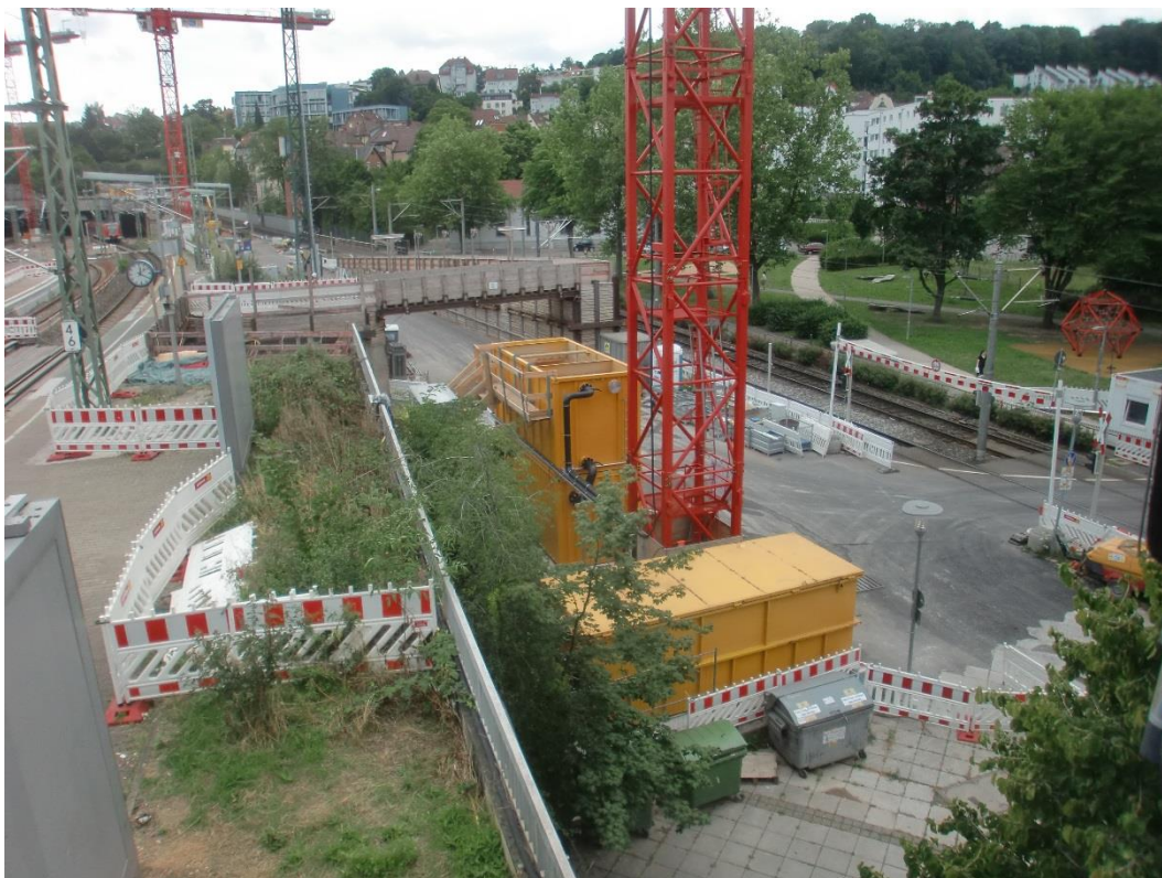
Abbildung 2: Blick auf das Baufeld bei Messende am 24.07.2017
