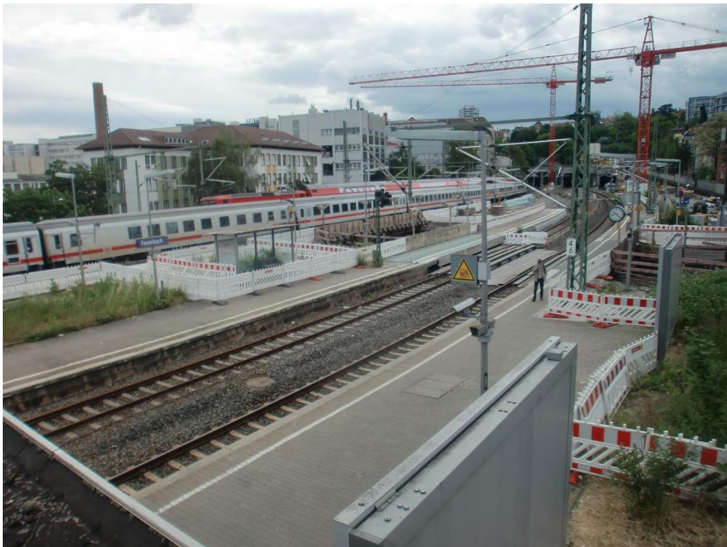
Abbildung 2: Blick auf das Baufeld bei Messende am 06.06.2017
