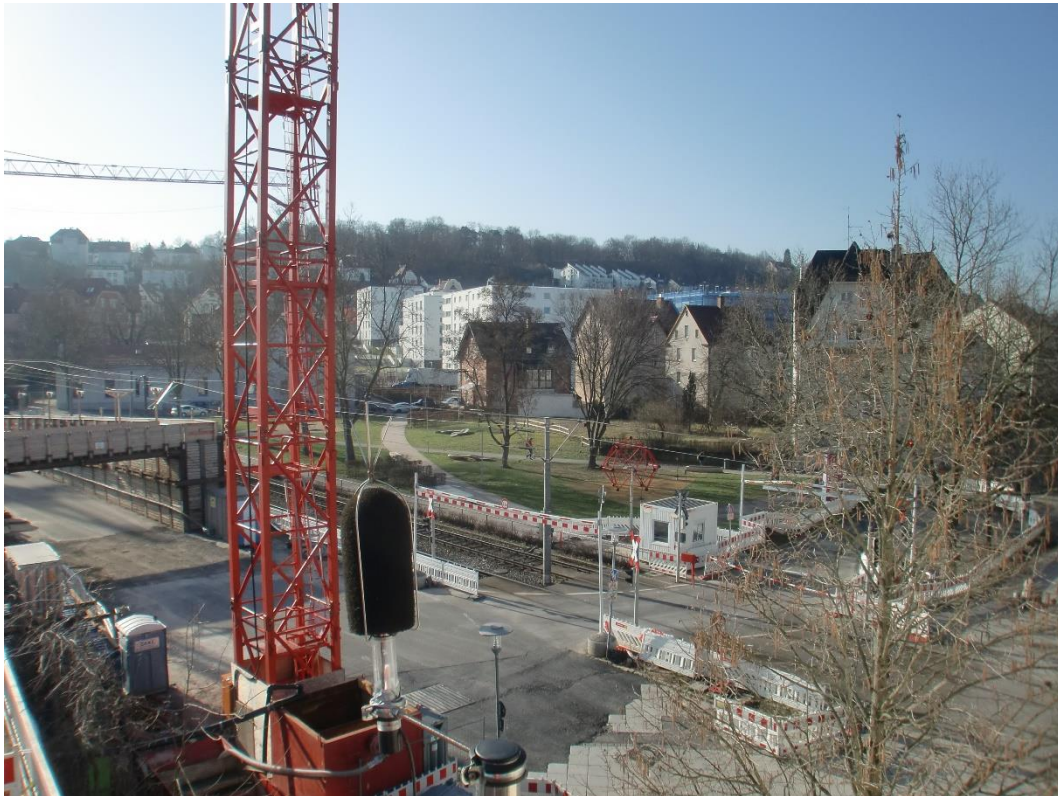
Abbildung 2: Blick auf das Baufeld bei Messende am 13.03.2017
