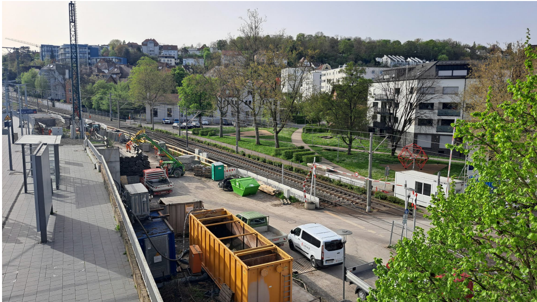
Abbildung 2: Blick auf das Baufeld bei Messende am 08.04.2024
