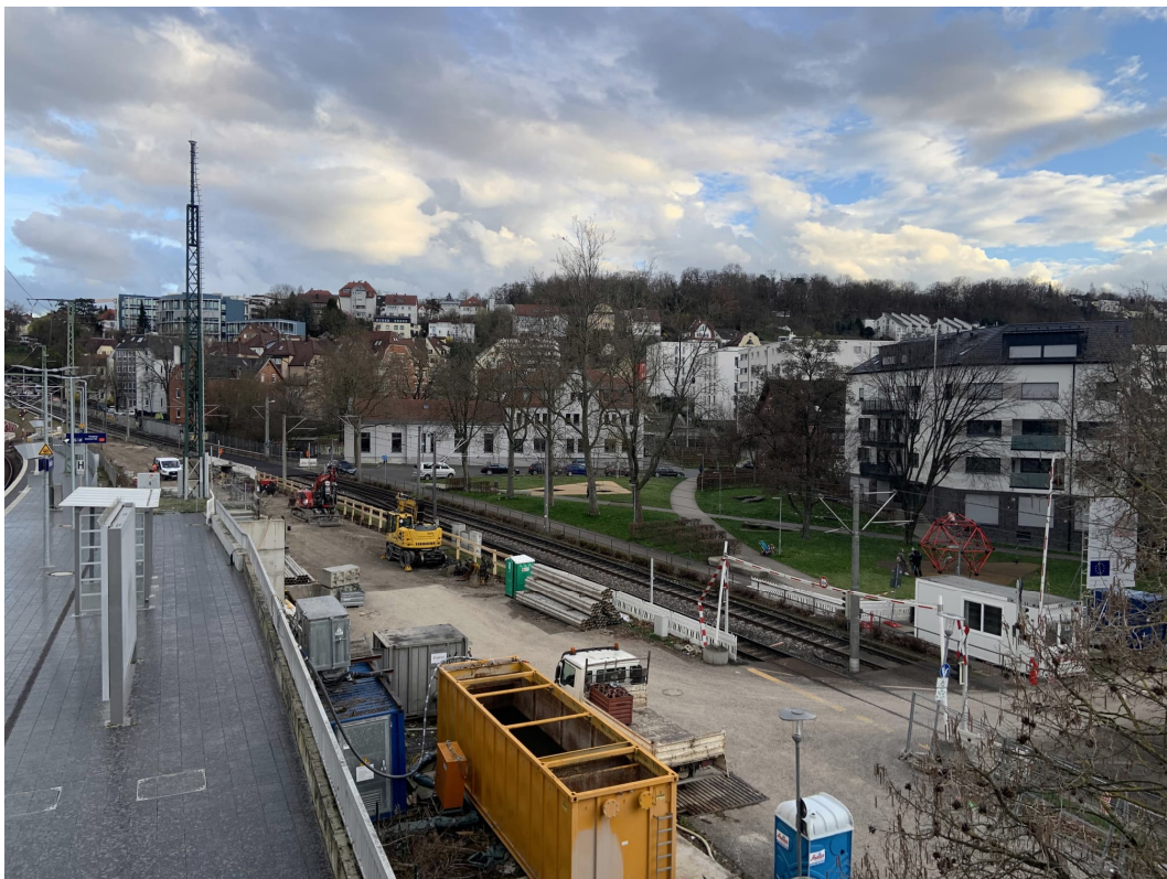
Abbildung 1: Blick auf das Baufeld bei Messbeginn am 11.03.2024
