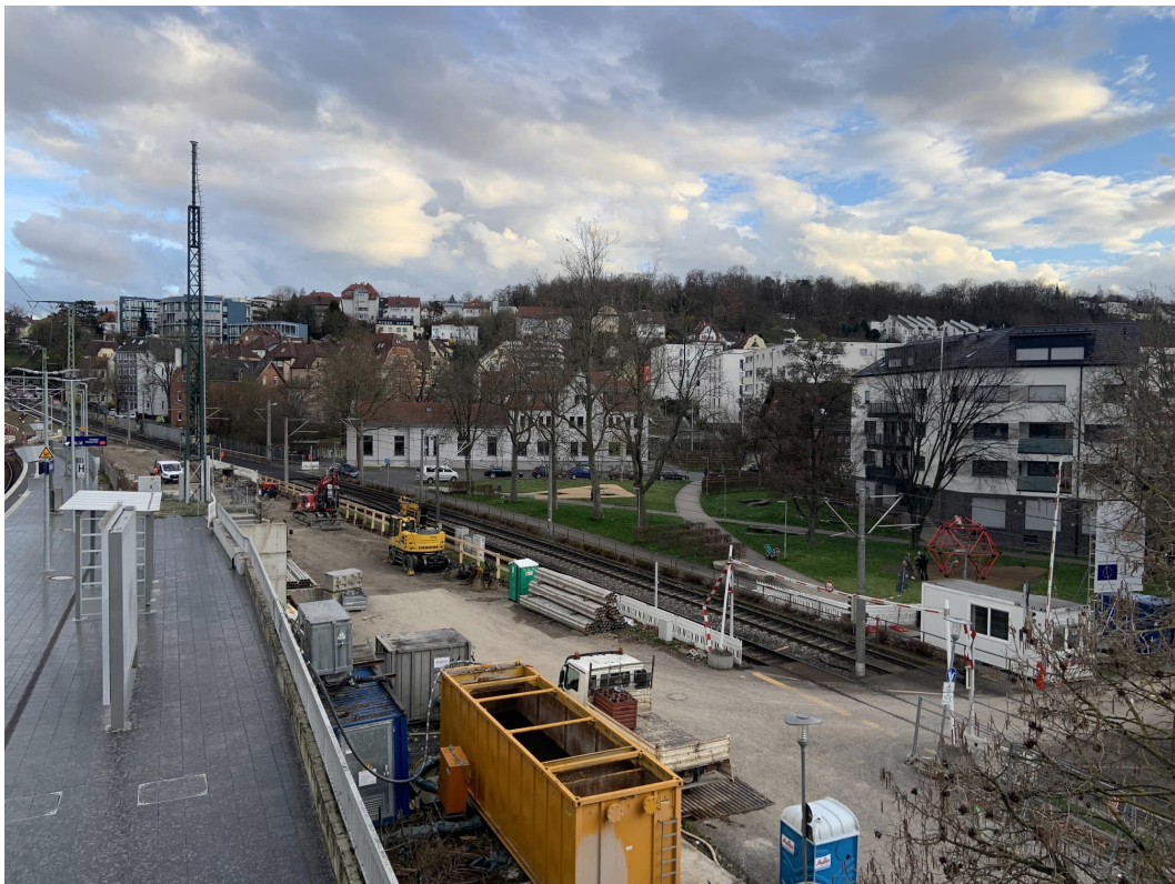
Abbildung 2: Blick auf das Baufeld bei Messende am 18.03.2024
