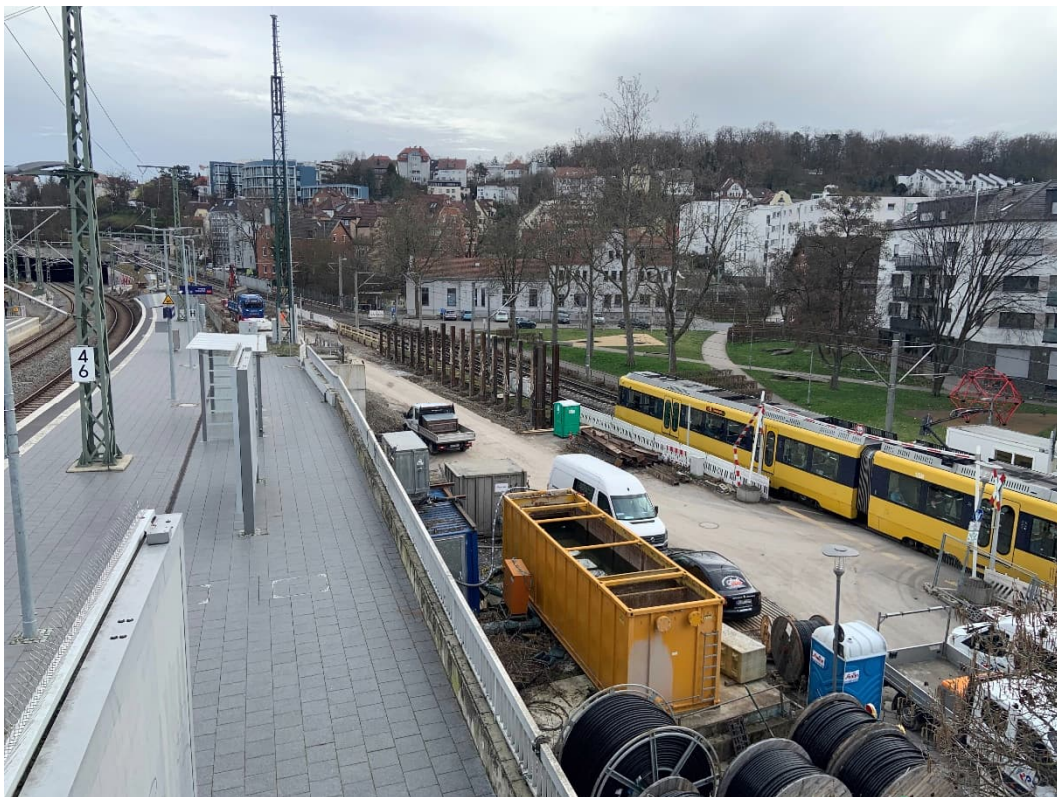
Abbildung 1: Blick auf das Baufeld bei Messbeginn am 26.02.2024
