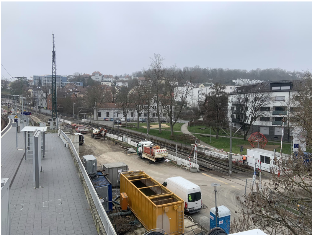
Abbildung 2: Blick auf das Baufeld bei Messende am 04.03.2024
