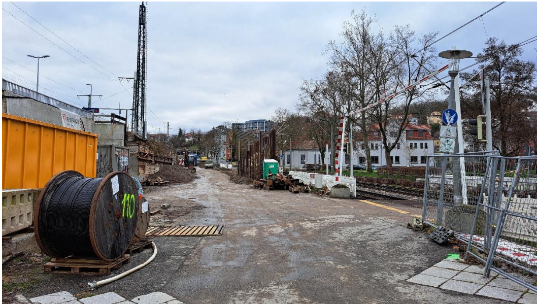
Abbildung 2: Blick auf das Baufeld bei Messende am 19.02.2024
