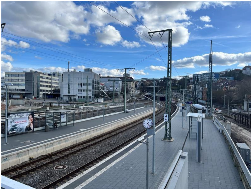
Abbildung 2: Blick auf das Baufeld bei Messende am 13.02.2024
