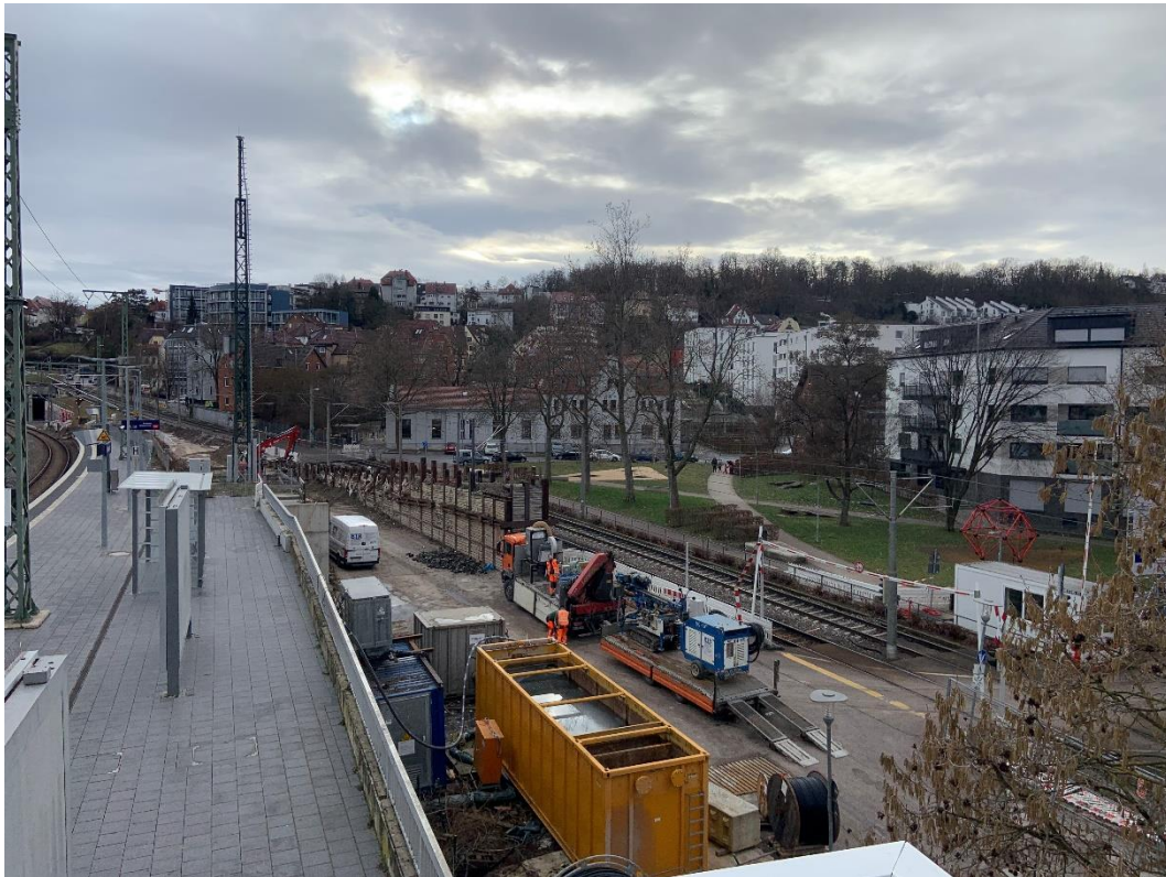
Abbildung 2: Blick auf das Baufeld bei Messende am 22.01.2024
