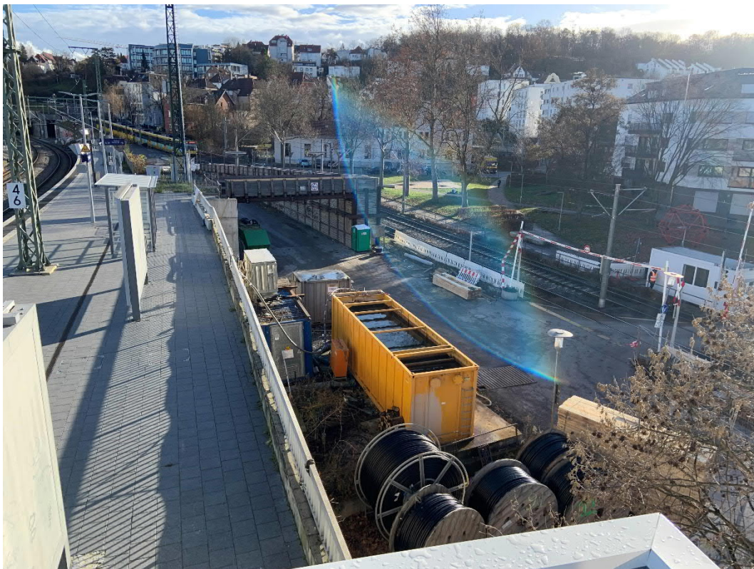
Abbildung 1: Blick auf das Baufeld bei Messbeginn am 11.12.2023
