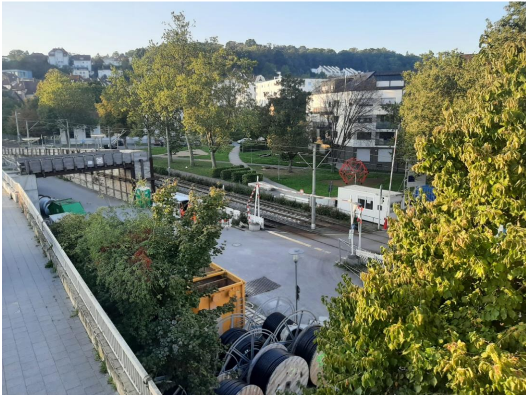
Abbildung 2: Blick auf das Baufeld bei Messende am 11.09.2023
