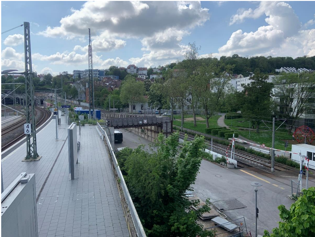
Abbildung 2: Blick auf das Baufeld bei Messende am 12.06.2023
