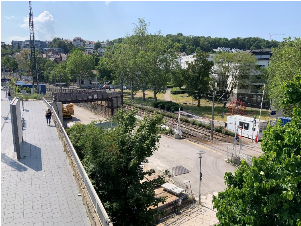
Abbildung 2: Blick auf das Baufeld bei Messende am 05.06.2023
