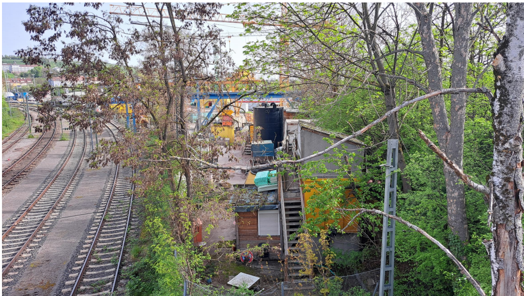
Abbildung 2: Blick auf das Baufeld bei Messende am 08.04.2024
