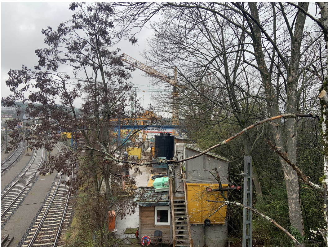
Abbildung 1: Blick auf das Baufeld bei Messbeginn am 01.04.2024
