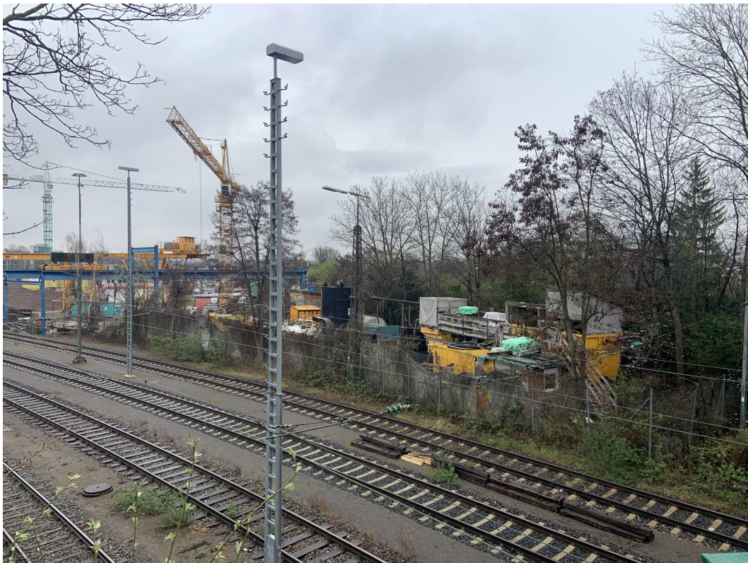
Abbildung 2: Blick auf das Baufeld bei Messende am 25.03.2024
