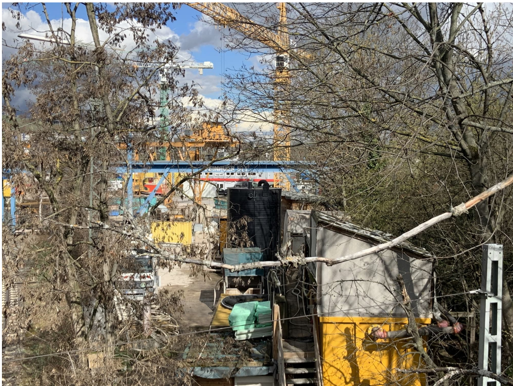
Abbildung 2: Blick auf das Baufeld bei Messende am 11.03.2024
