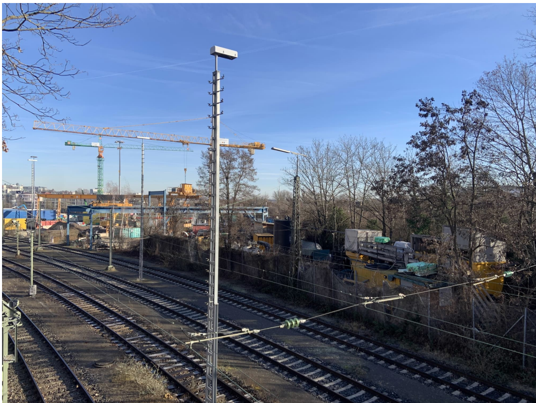
Abbildung 1: Blick auf das Baufeld bei Messbeginn am 19.02.2024
