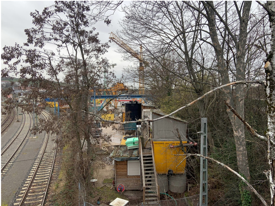
Abbildung 2: Blick auf das Baufeld bei Messende am 26.02.2024
