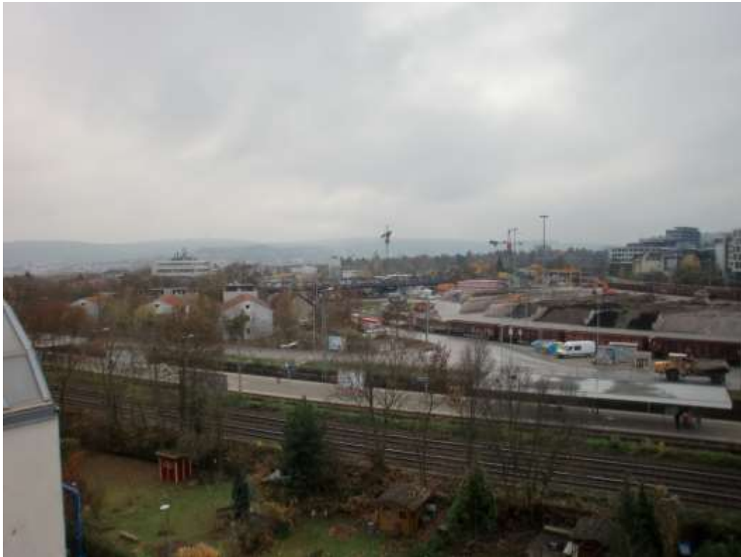
Abbildung 2: Blick auf das Baufeld bei Messende am 24.11.2016
