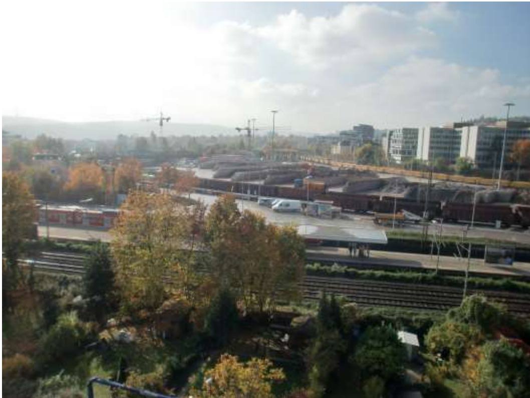
Abbildung 2: Blick auf das Baufeld bei Messende am 27.10.2016
