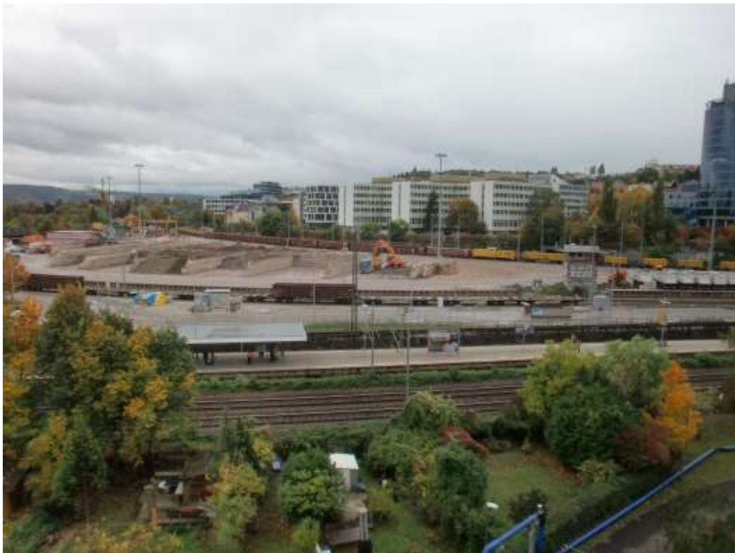
Abbildung 1: Blick auf das Baufeld bei Messbeginn am 20.10.2016
