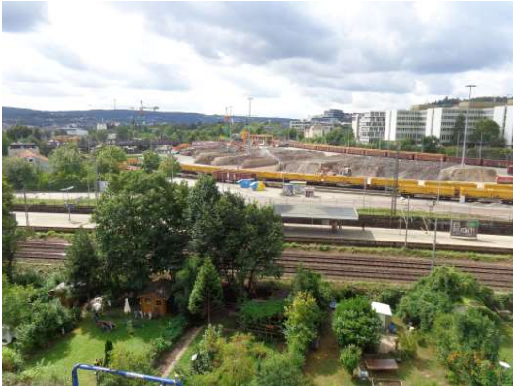
Abbildung 2: Blick auf das Baufeld bei Messende am 29.08.2016
