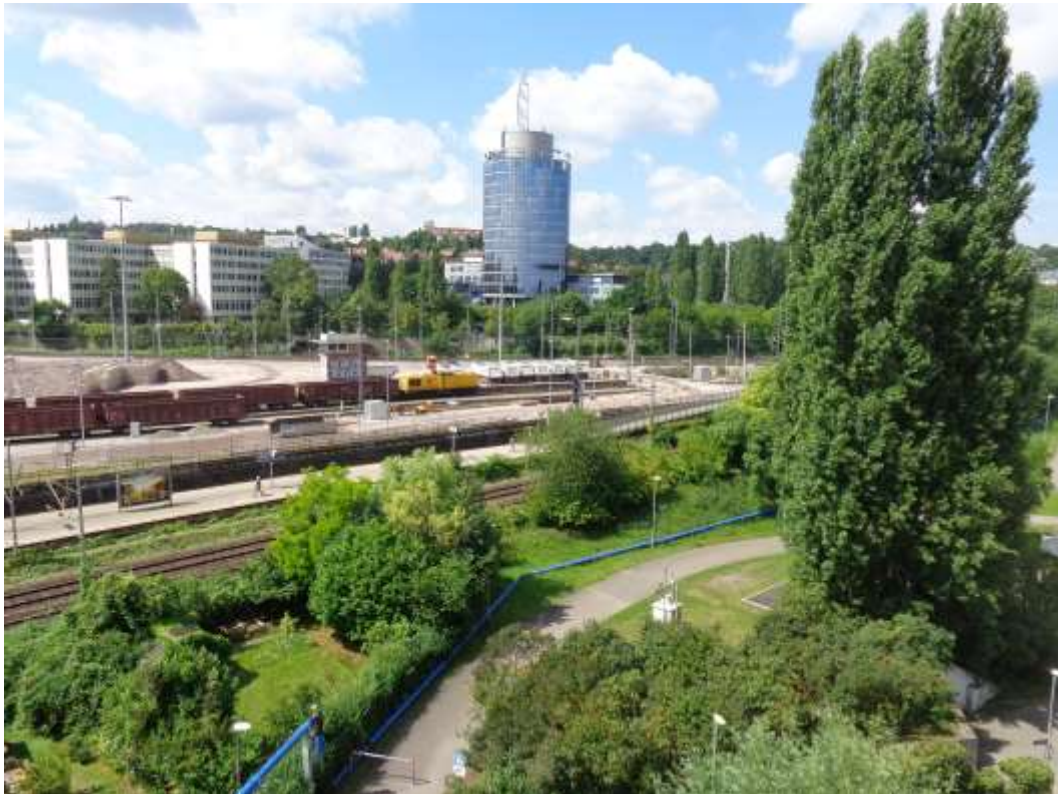
Abbildung 2: Blick auf das Baufeld bei Messende am 01.08.2016
