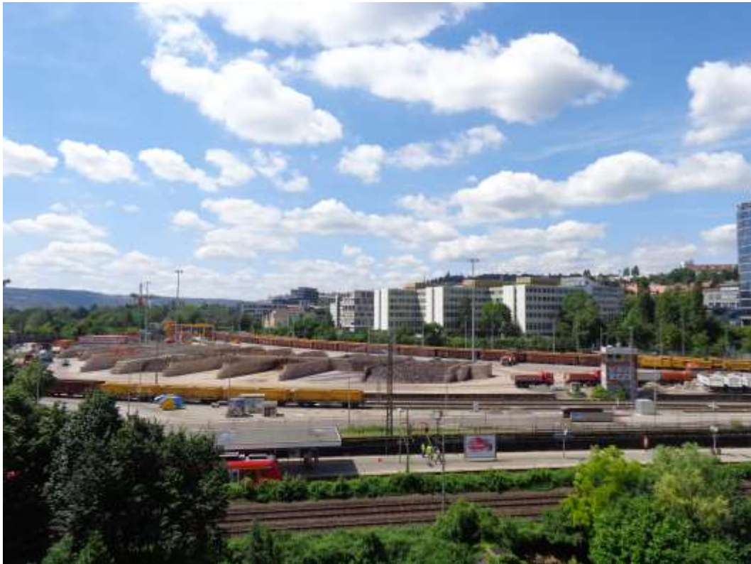
Abbildung 2: Blick auf das Baufeld bei Messende am 04.07.2016
