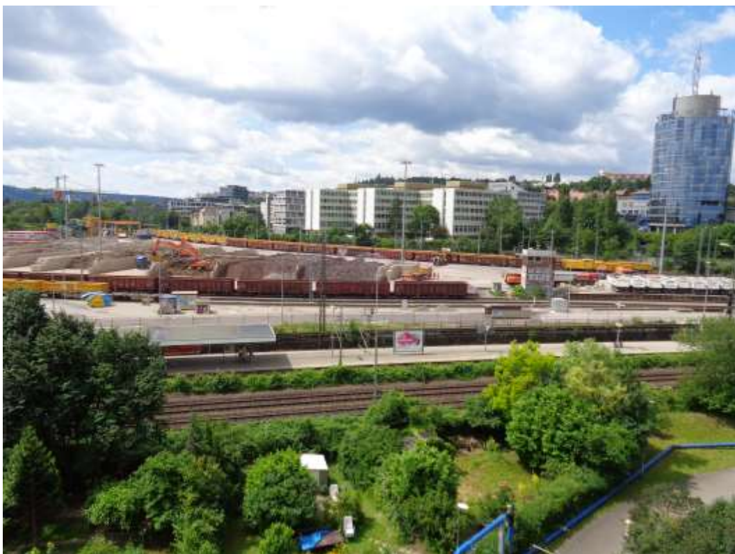
Abbildung 1: Blick auf das Baufeld bei Messbeginn am 27.06.2016
