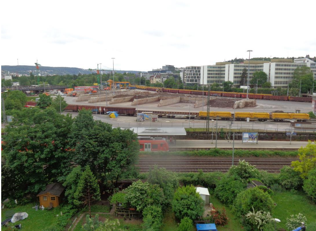
Abbildung 1: Blick auf das Baufeld bei Messbeginn am 30.05.2016
